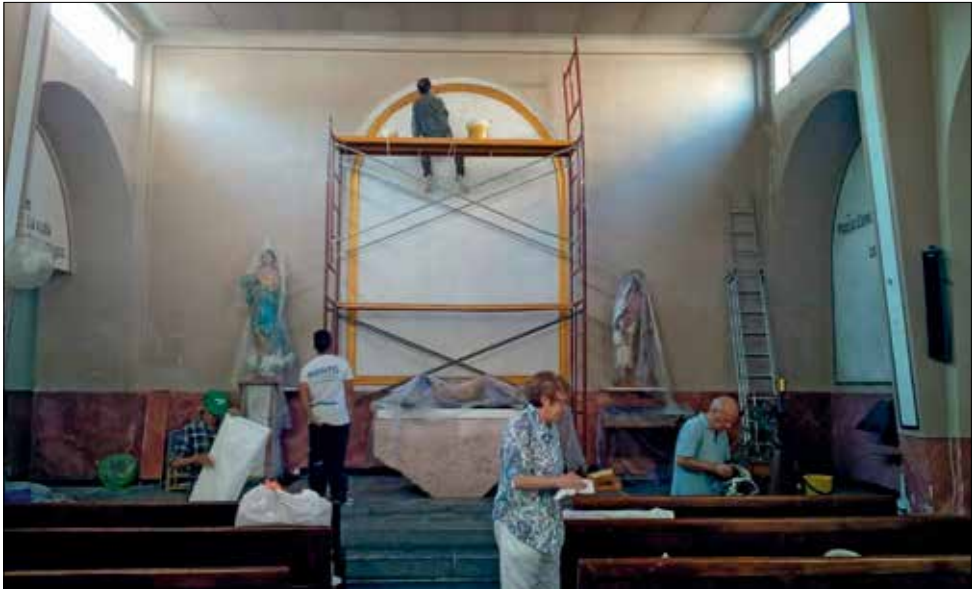
Obras de reforma en la Iglesia 2018.
