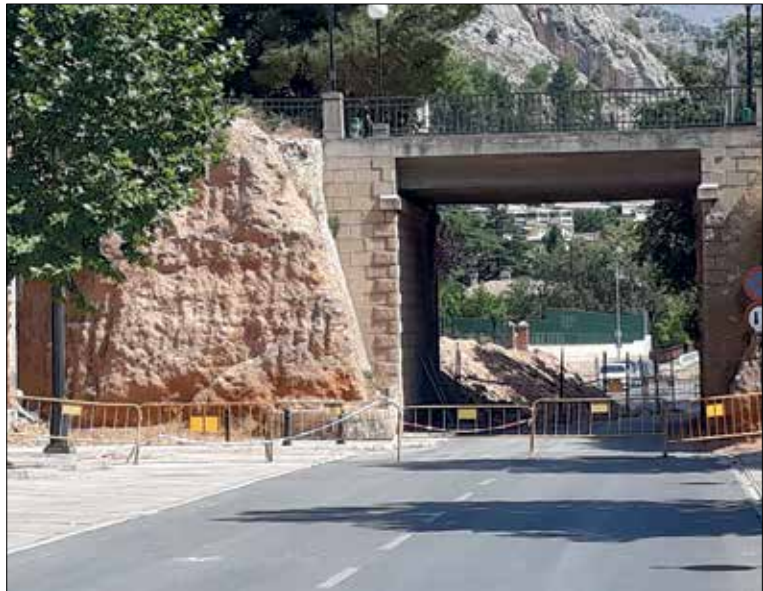
Construcción del carril Bici, 2019.
