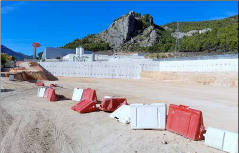
Inicio de la construcción del edificio, 2020.
