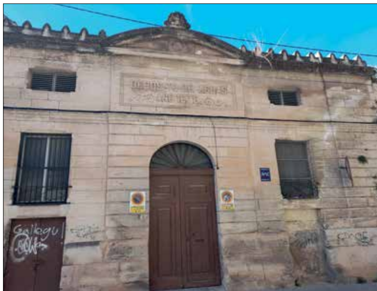
Depósito de agua El Cami 1878.
