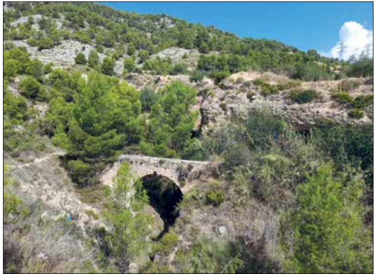
Viaducto agua Polop Barxell y balsas Castellar.
