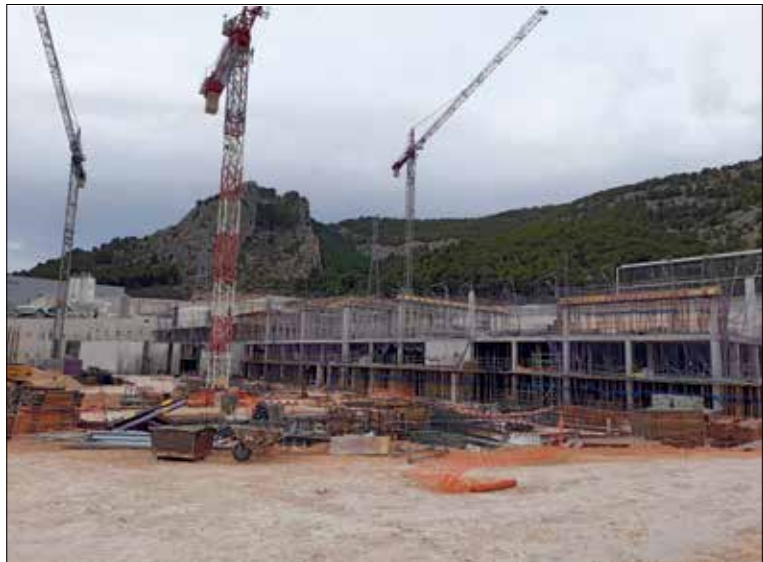
Obra de construcción AITEX, 2021.
