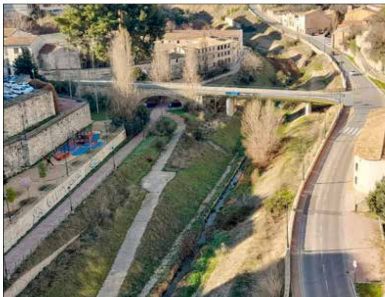
Puente de la salida a Madrid, 2021.
