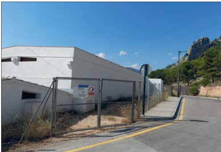
Déposito de agua Trencacaps.
