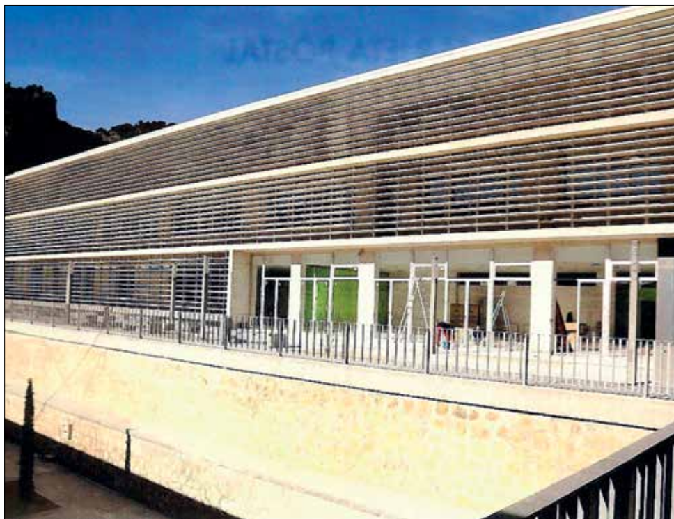
CIP de F.P. terminado.
