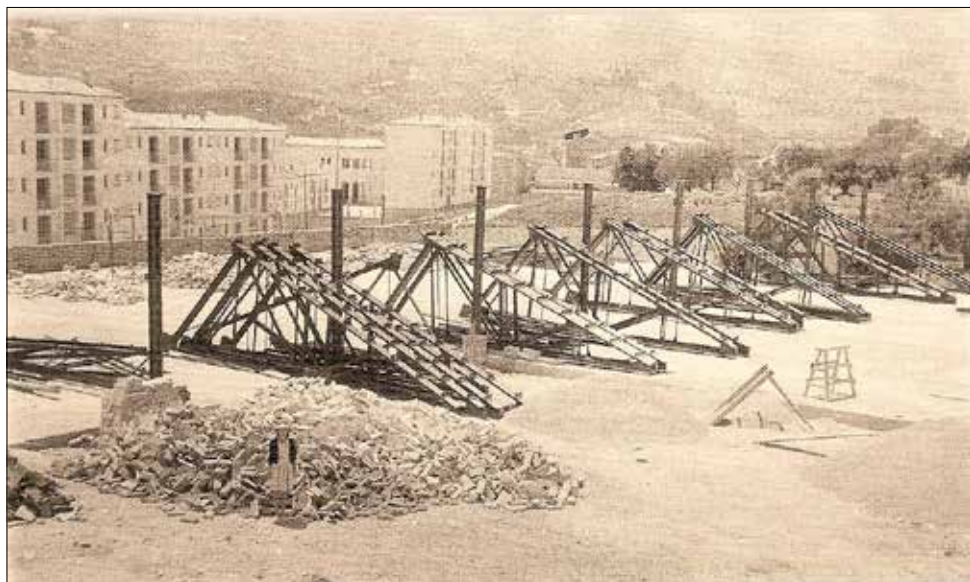
Construcción de la factoría manufacturas Carbonell, 1966.
