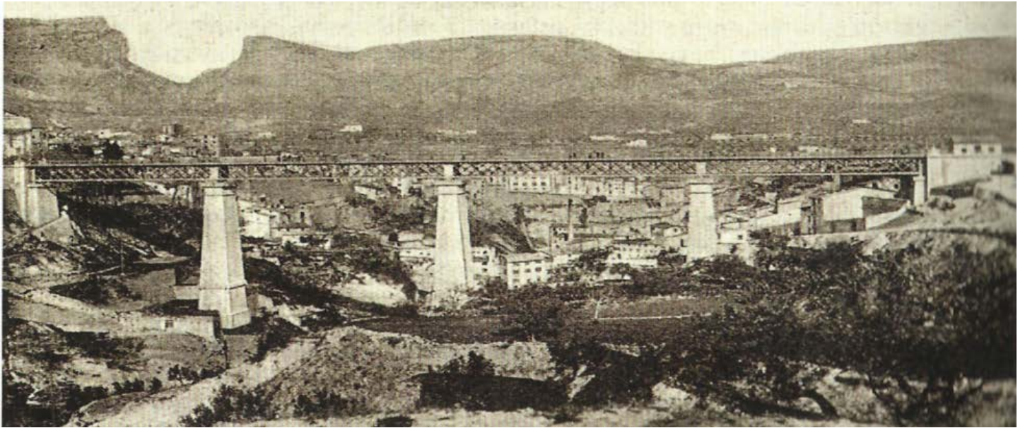
Viaducte de Canalejas, inaugurat en 1907, Arxiu José Crespo Colomer
