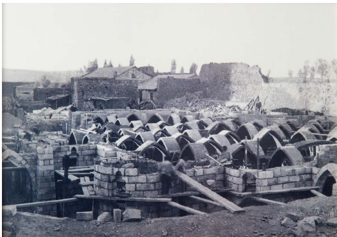
Ilustración 2. Inicio de las obras. En 1890 ya se estaban construyendo las bóvedas del sótano y se había levantado el primer tramo de fachada.
