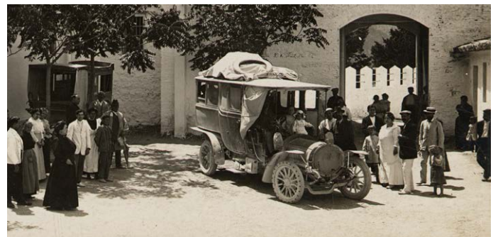
En esta imagen de la llegada de un automóvil a Fuente Podrida (Requena) vemos el estado en el que quedaban después de un viaje. Las ventanas se cerraban con lonas para impedir la entrada del polvo y el viento. (bivaldi.gva.es)
