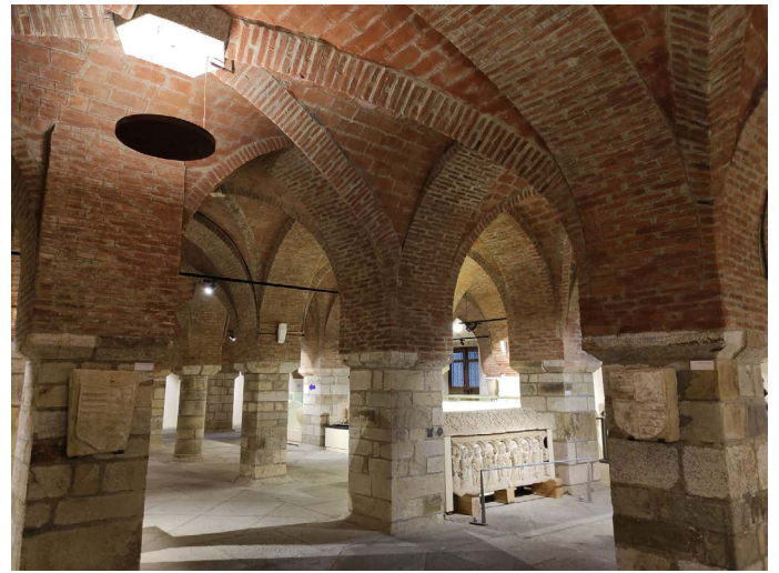
Ilustración 3. Gaudí prescindió en el sótano de los detalles decorativos. Combinó el ladrillo visto con la piedra y no presenta divisiones internas.
