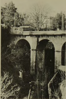
13. Fotografía actual del puente nuevo de la estación de La Roque, construido el año 1862. (Foto Studio).
