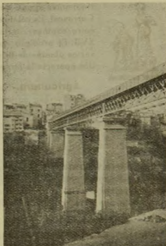
Viaducto de Canalejas
