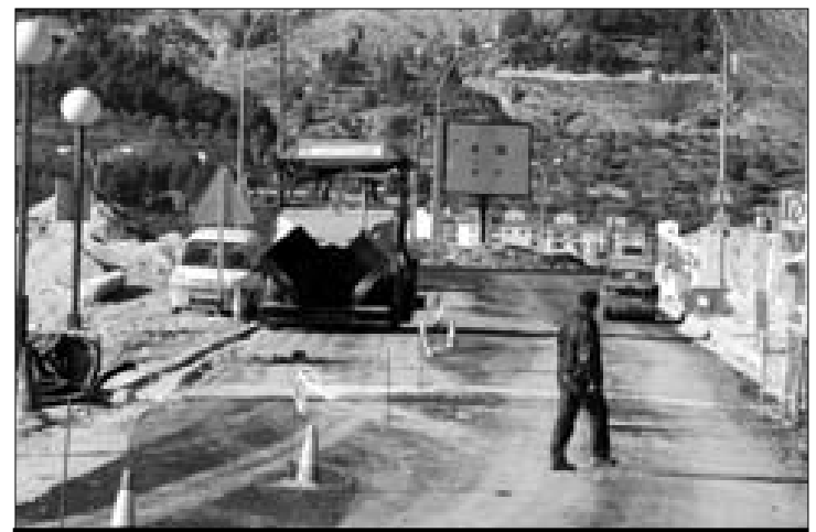
Ayer se inició el asfaltado de la Avinguda d'Elx.
