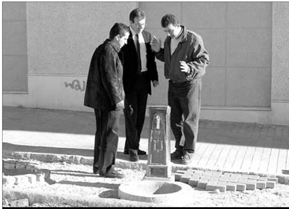
El alcalde visitó ayer las obras de la plaza Evaristo Botella.
