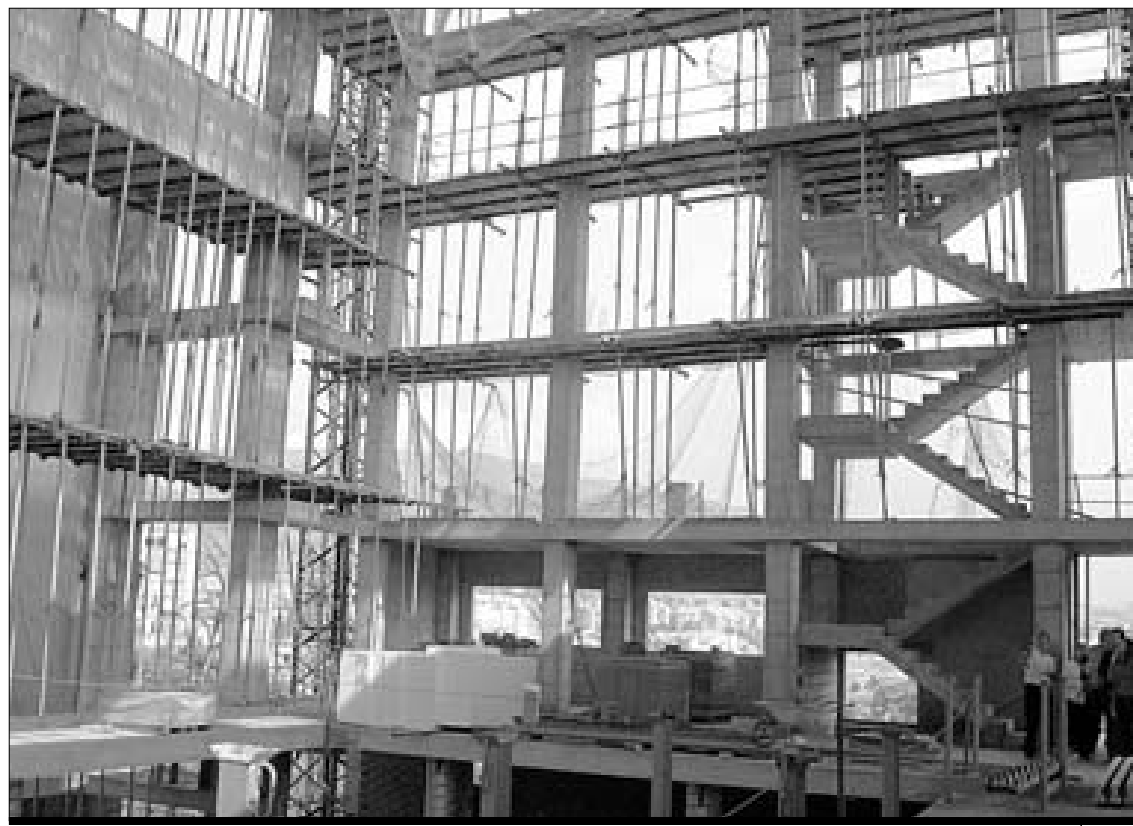
Obras de construcción del nuevo Teatro Calderón.
