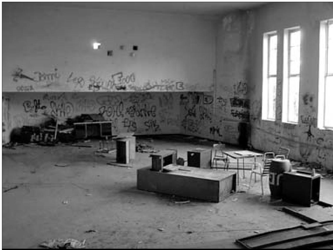
El edificio que se derribará se encuentra en muy mal estado.
