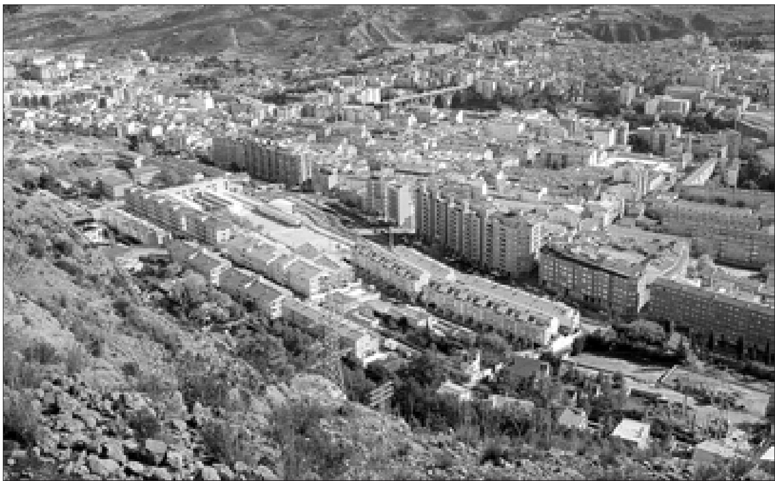
La laderas del monte San Cristóbal ofrece riesgos de desprendimientos por sus características.
