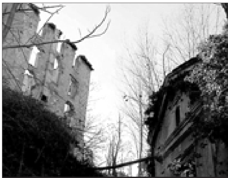
En veinte años el deterioro se ha acelerado.
