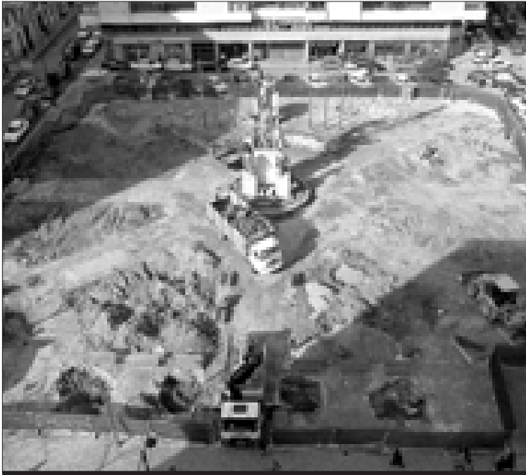
Las obras del p arking seguir n adelante.
