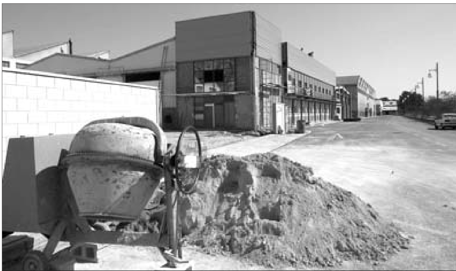
Antes de finalizar el presente año más de la mitad de las empresas estarán en sus nuevas instalaciones
