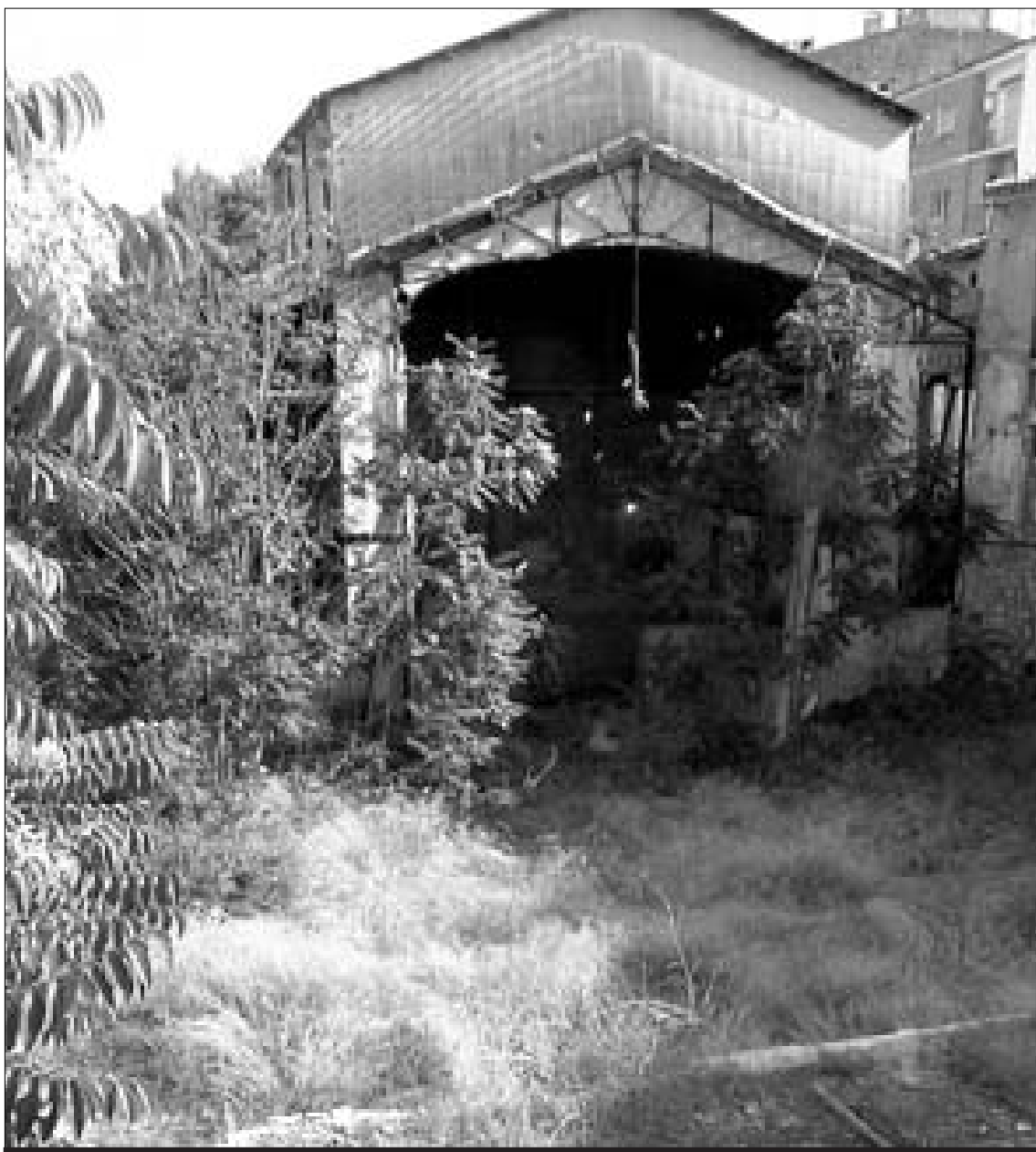
El solar del antiguo Teatro Circo está afectado por los tirantes que sujetan la ladera
