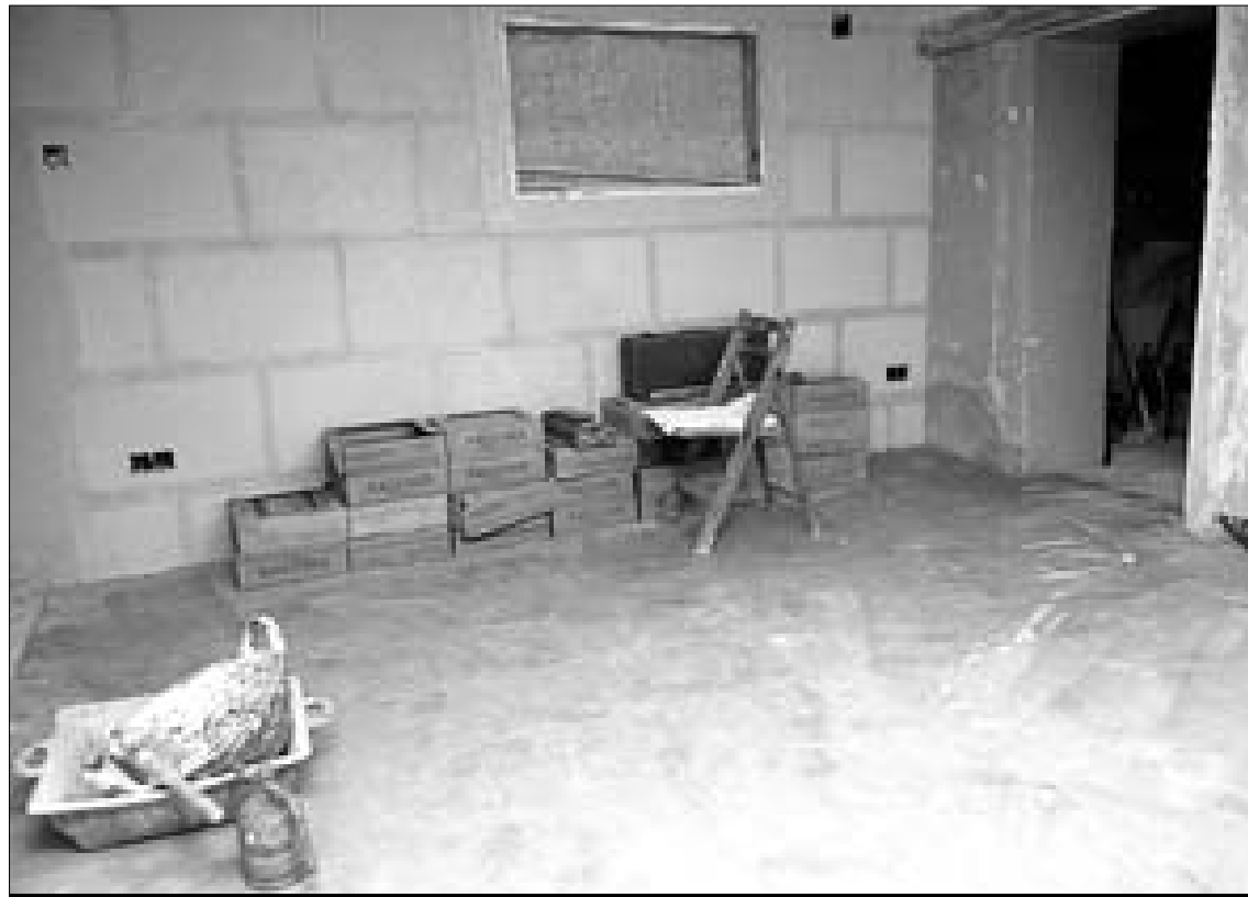
Los trabajos para adecuar la planta superior del Panical están ya muy avanzados.
