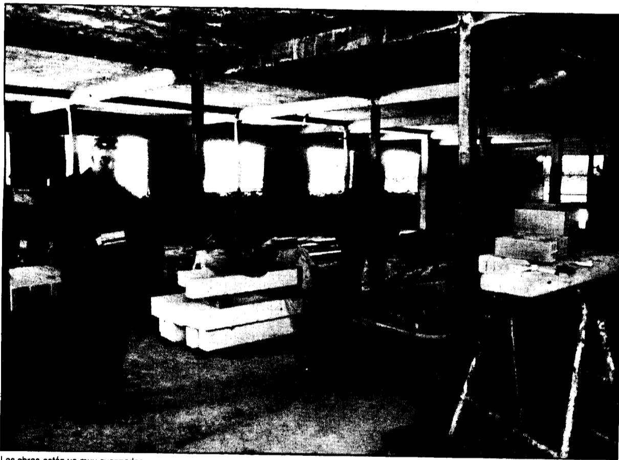
Las obras están ya muy avanzadas
