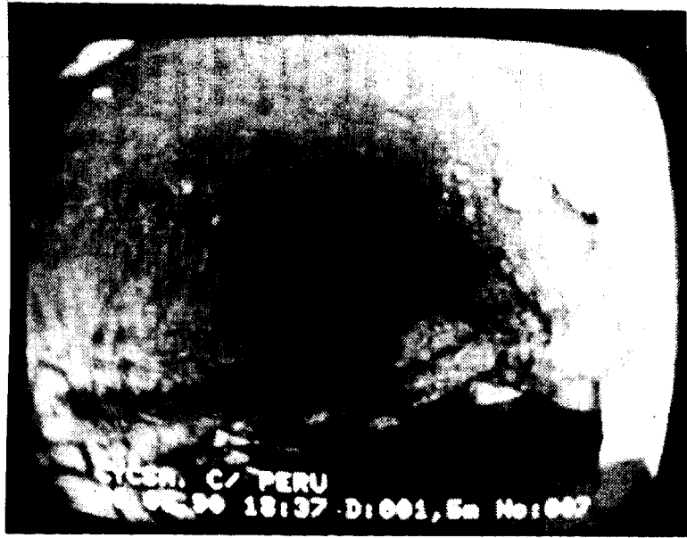
Los desprendimientos se ven claramente en las fotografías realizadas por el robot.
