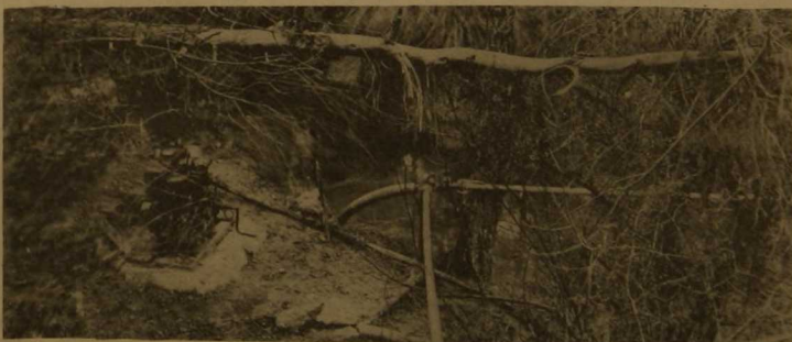
Bomba ubicada junto al río, para proyección de agua al equipo técnico.
